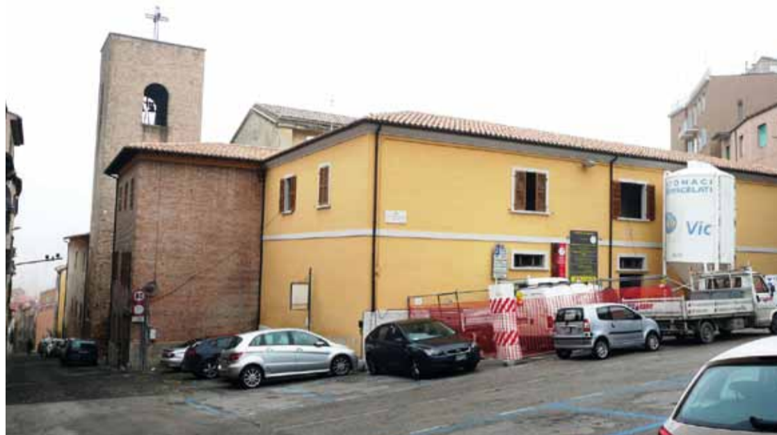
Il Complesso in ristrutturazione
