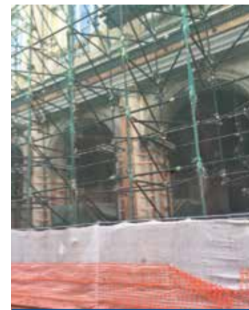
Palazzo messo in sicurezza
