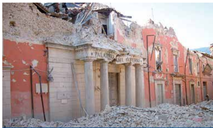
Il Palazzo del Governo dopo il terremoto
